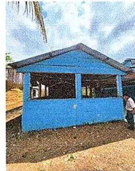
Foto 4: Cambio de Cubierta de lamina
