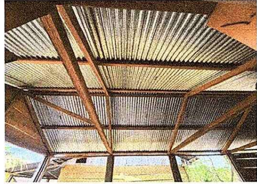
Foto 2: Sustitucion de entrecutura de techo por metal y cubierta de lamina
